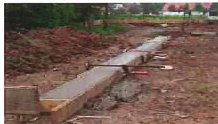
Semelle filante en béton coulé sur place
