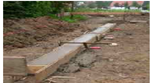
Semelle filante en béton coulé sur place
