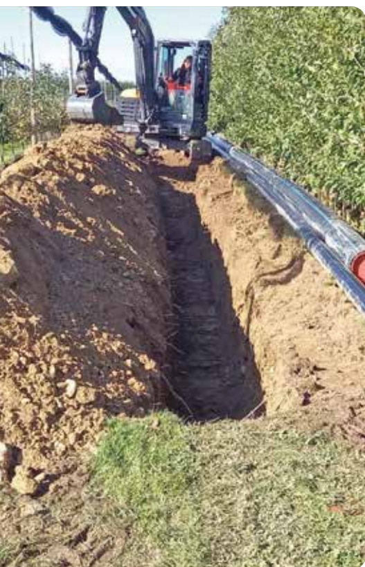
14 Kilometer Leitungen wurden verlegt. Des conduites ont été posées sur 14 km. ZVG
