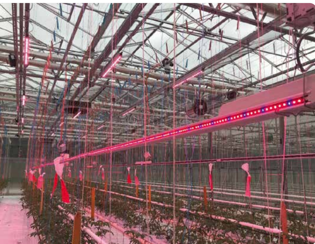
Serre de tomate hors-sol avec éclairage LED-Interligne et LED-TOP. AGROSCOPE
