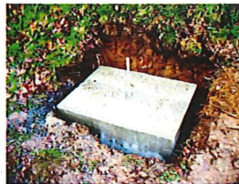
Fondazione costituita da più elementi di calcestruzzo
