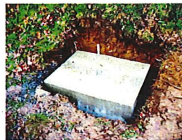
Fondazione costituita da più elementi di calcestruzzo
