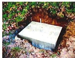
Fundamentierung aus mehreren einzelnen Betonelementen
