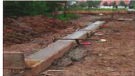
Streifenfundament gegossen
