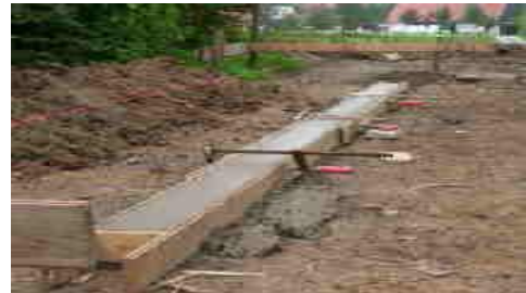
Streifenfundament gegossen
