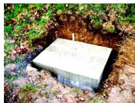
Fundamentierung aus mehreren einzelnen Betonelementen
