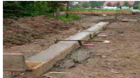
Streifenfundament gegossen
